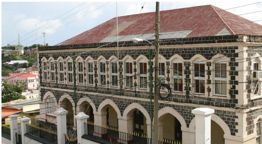
El Parlamento de Granada, antes de ser parcialmente destruido por el huracán Iván, en 2004. La re-construcción continúa.
