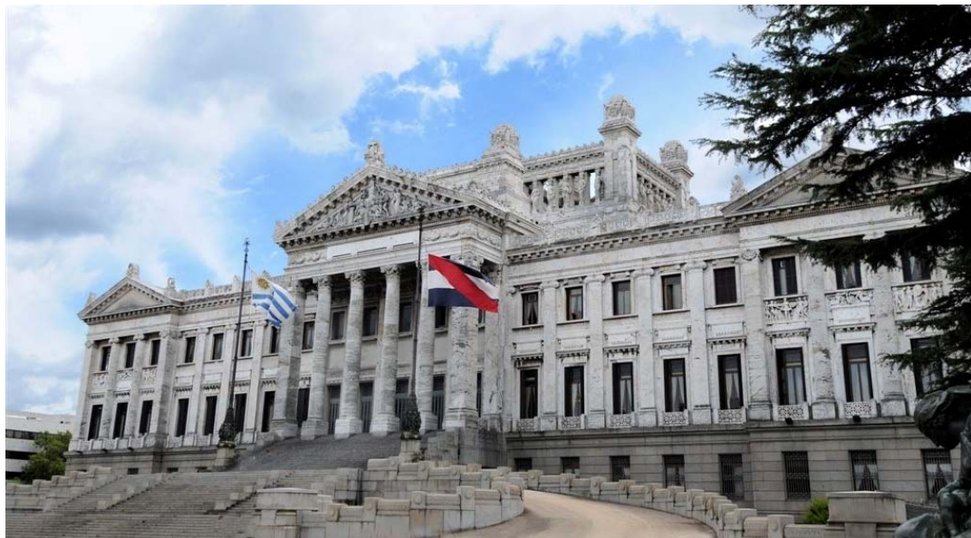
El proyecto original del Palacio Legislativo, concebido por el arquitecto Vittorio Meano, sufrió importantes modificaciones.
